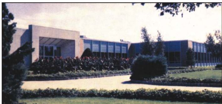
NEW JERSEY - FLORHAM PARK - Fábrica e escritório central.
